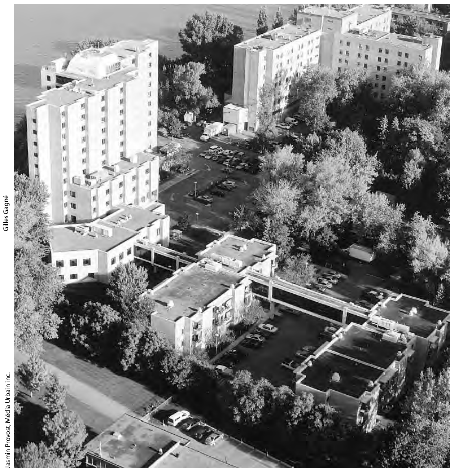
Vue aérienne des passerelles.
