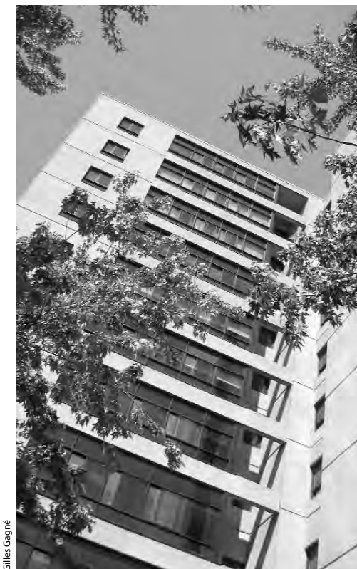
Photo en contre-plongée de la Résidence.
